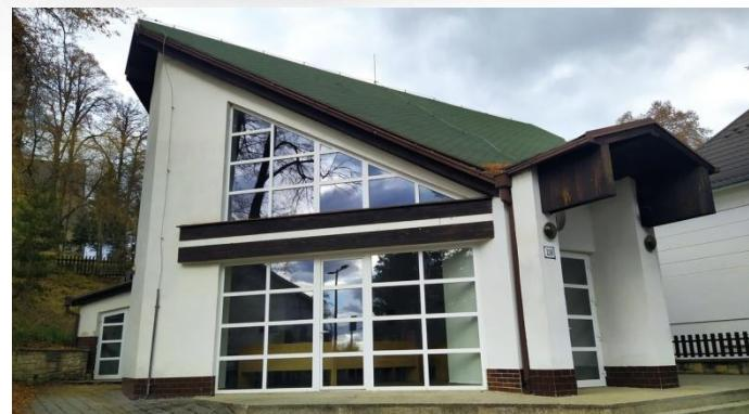
**Architektúra** – Objekt domu smútku je založený na základových pásoch. Podlahy sú vyhotovené podľa účelu využitia jednotlivých miestností. Objekt je murovaný. Strecha na objekte je tvorená šikmými plochami, tvorí ju drevený krov. Okná a dvere na objekte sú vymené za plastové s izolačným zasklením.
